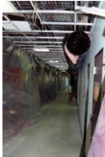
MEB hallway (before)
